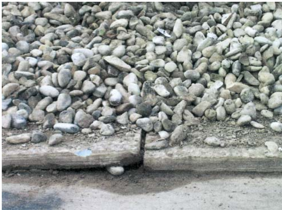
Fig 5 :Infiltrazioni di ghiaia tra i pannelli originali
