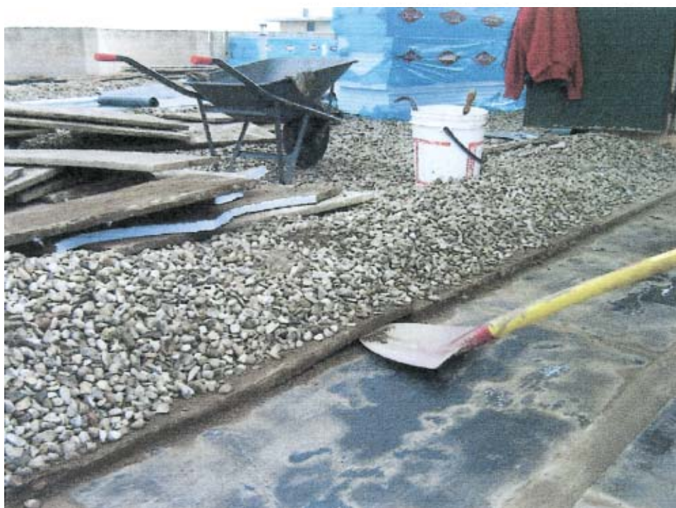
Fig 2 :Rimozione dalla copertura del materiale originale
